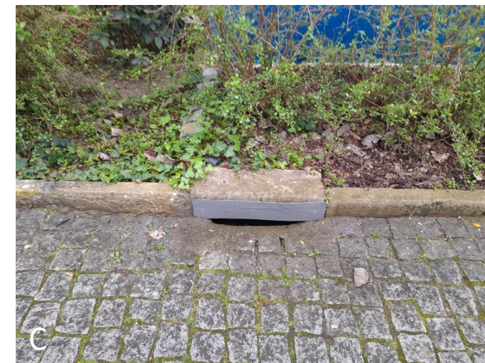
C Dimensões: 70x15cm Localização: Edifício C, corredor principal
